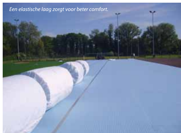
Vlakheid van de onderbouw is cruciaal.
