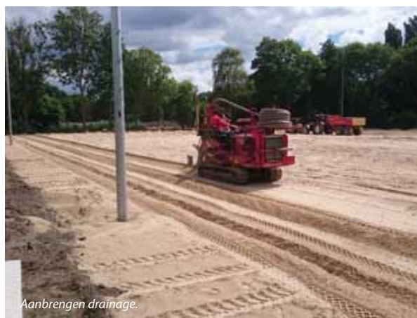
Aanbrengen van de onderbouw.
