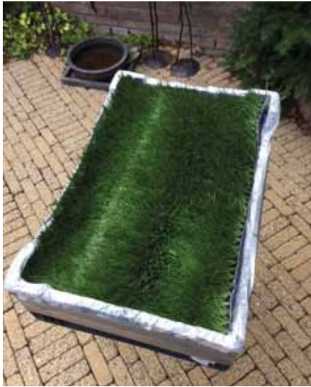
Daar bovenop kunstgras met een waterdoorlatende backing
