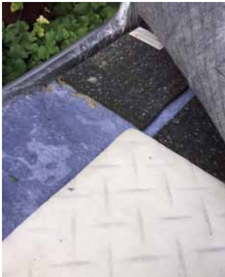
Ook het drukvezeldoek, de shockpads en de backing zijn nog vochtig
