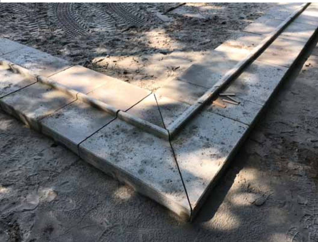
Een opstaande rand van 14 cm moet voorkomen dat het granulaat uit het veld verdwijnt
