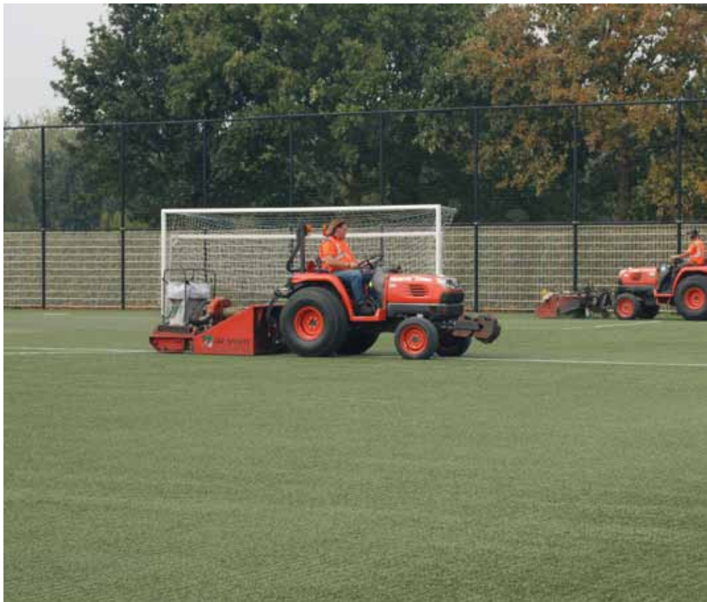
Met de diepe borstelmachine Extreme Clean, de wiedepping en een gewone borstelmachine wordt de TPE-infill gedecompacteerd, de infill verdeeld en worden de velden tot slot afgeborsteld.
