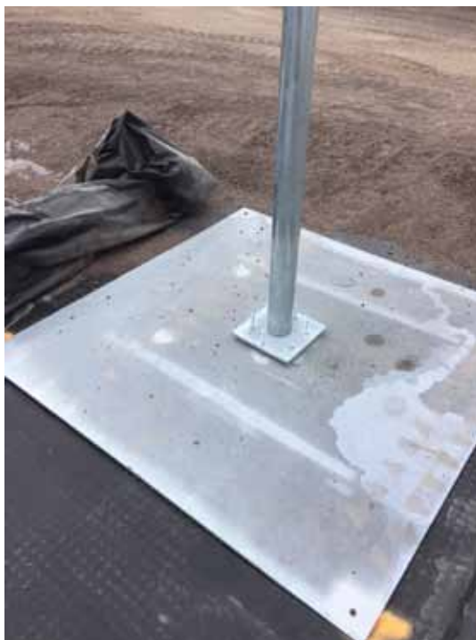
Verzinkte stalen platen, 1 cm dik (foto Gerrit de Koe)
