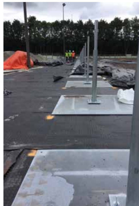
Verzinkte stalen platen met houders om het hekwerk op te monteren (foto Gerrit de Koe)
