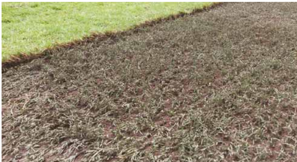
3 cm toplaag werd verwijderd, waardoor de Desso Grassmaster-vezel weer bloot komt te liggen.
