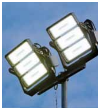
3. Multilayer-leds in een behuizing.
