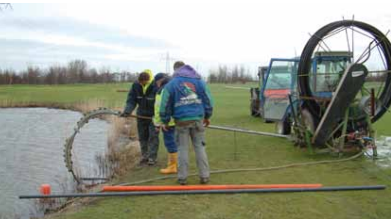
Doorspuiten van drainage.
