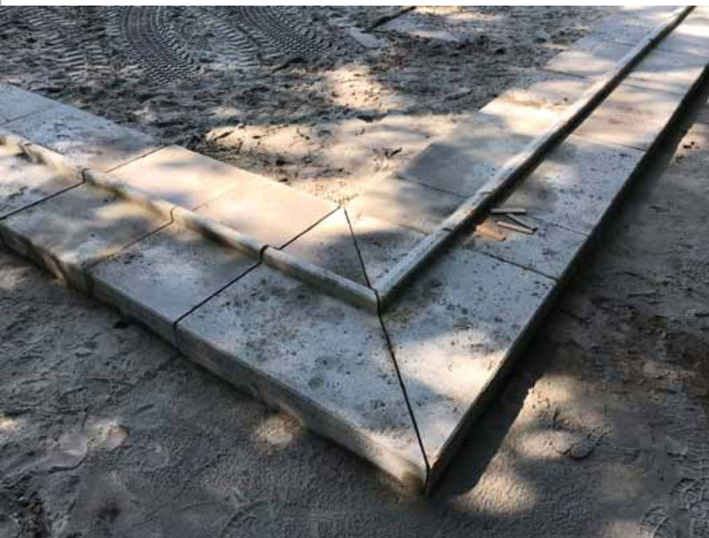
Een opstaande rand van 14 cm moet voorkomen dat het granulaat uit het veld verdwijnt
