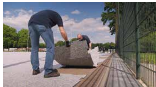
Eén voor één werden de velden voorzien van de duurzame ProPlay shockpad onderlaag die zorgt voor een stabiele ondergrond en krachtige demping.
