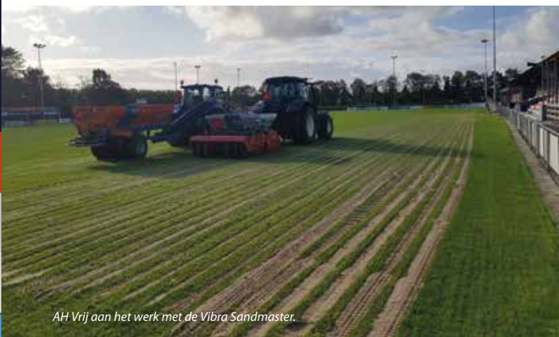
Na het aanbrengen van de zandsleuven begon Tarkett met prikken van de vezels.
