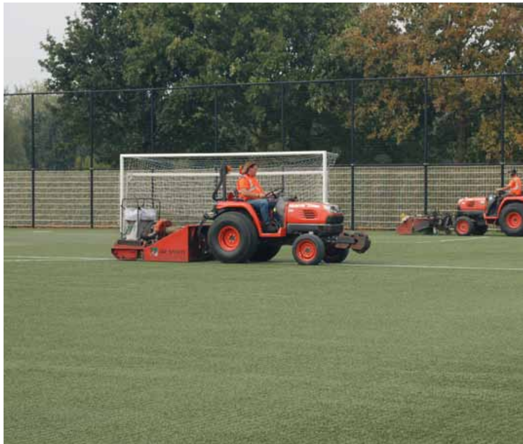
Met de diepe borstelmachine Extreme Clean, de wiedege en een gewone borstelmachine wordt de TPE-infill gedecompecteerd, de infill verdeeld en worden de velden tot slot afgeborsteld.
