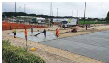
Voor de aanleg van SuperSub komen slechts twee vrachtwagens naar de locatie.
