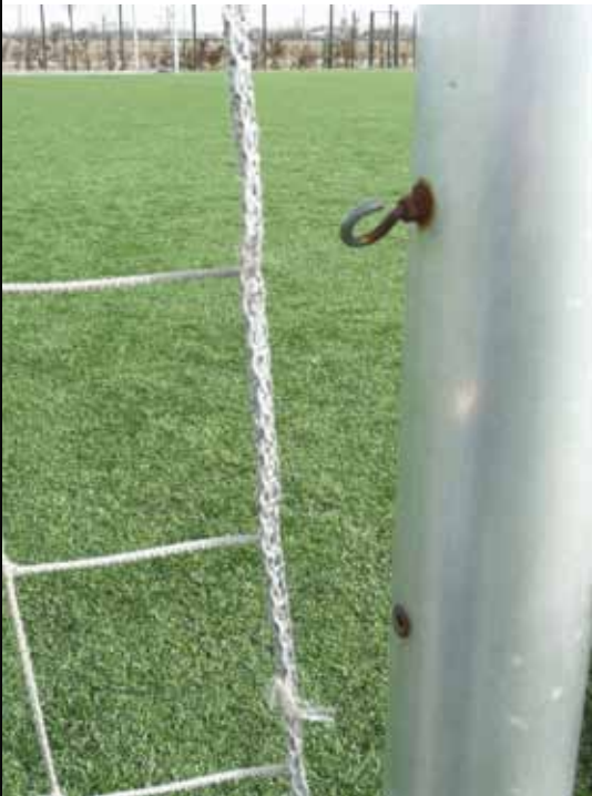
Een veelvoorkomend veiligheidsrisico bij voetbaldoelen: open nethaken.
