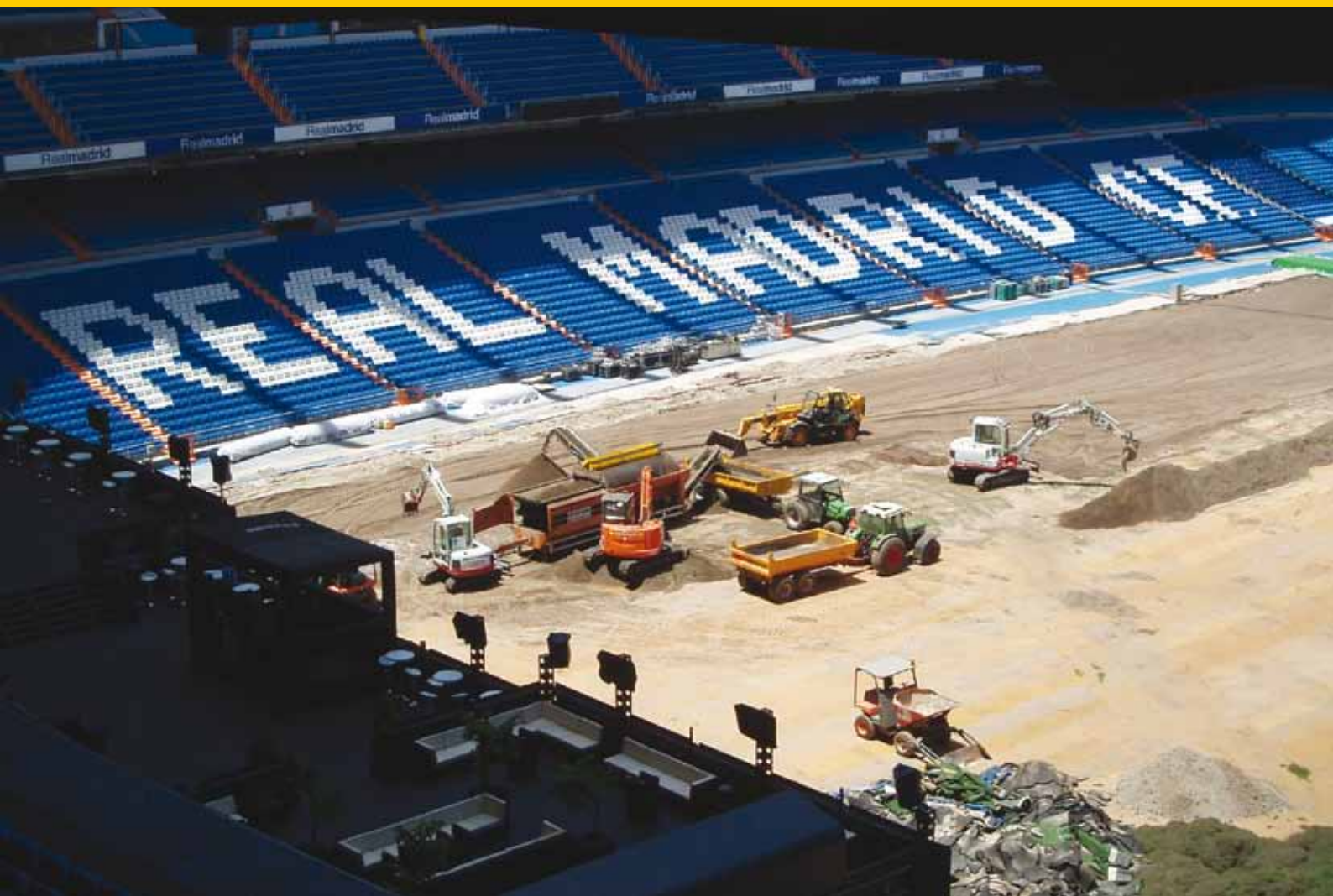
Foto van anderhalf jaar geleden. Op het veld staat een grote trommelzeef van AH Vrij die de Grassmaster-vezels uit de toplaag zeef. (Foto AH Vrij)
