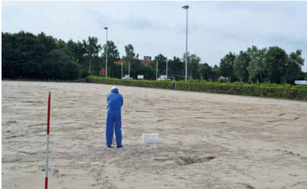
Enviterra aan het werk op locatie.
