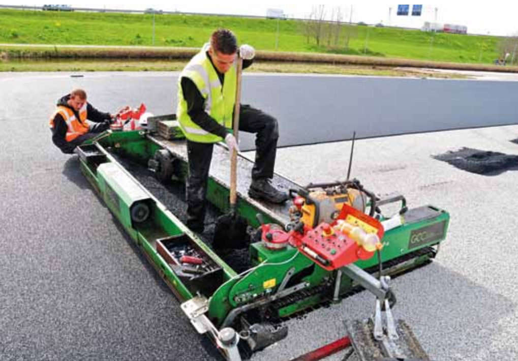
Aanleg van een e-layer door Ten Cate Greenfields.
