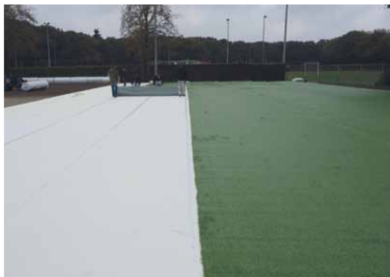
Installatie Ten Cate Total Solutions shockpad op De Zweef, Nijverdal.
