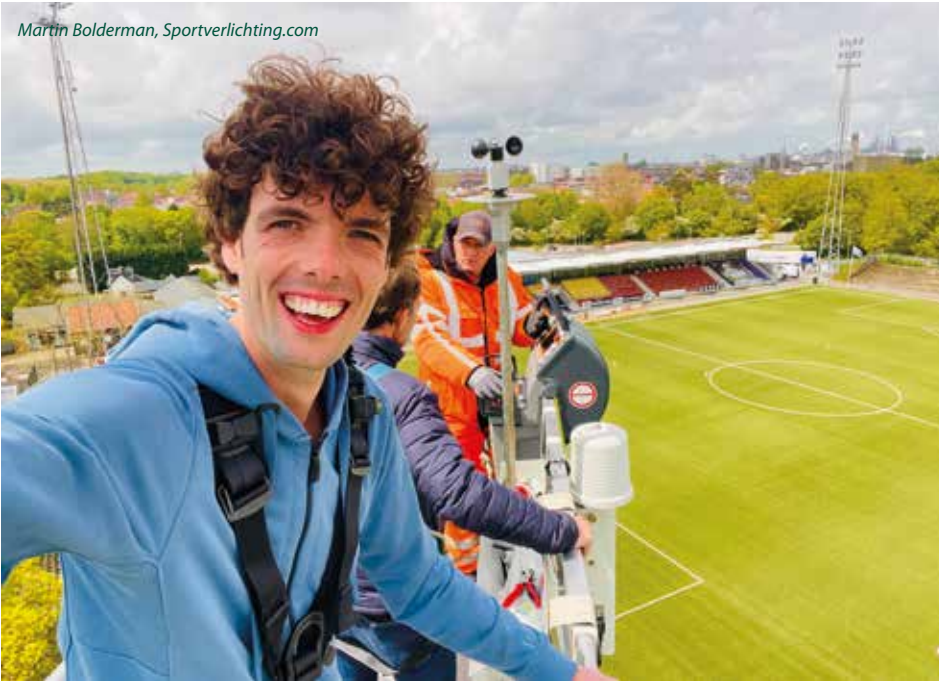
Eind mei werden de lampen geïnstalleerd.
