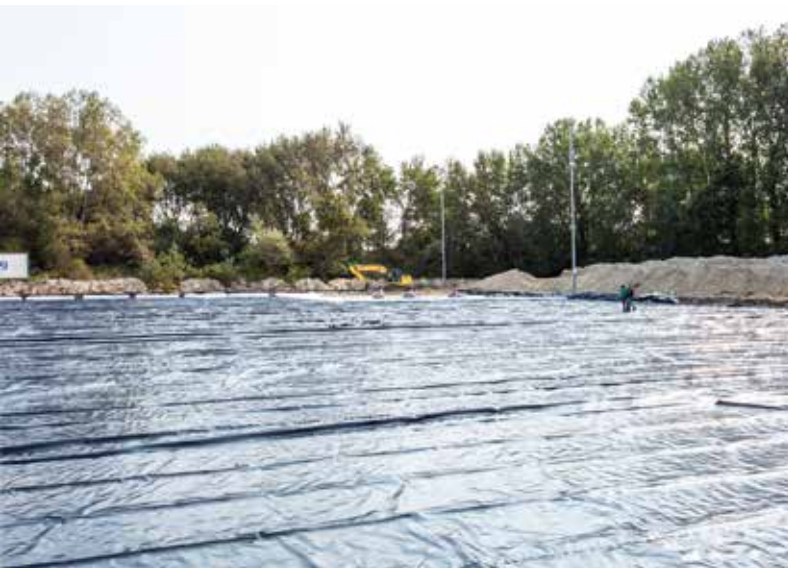
Een ondoordringbaar zeil voorkomt dat het water in de bodem trekt.
