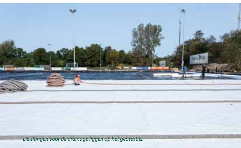
Op dat zeil is geotextiel aangebracht.
