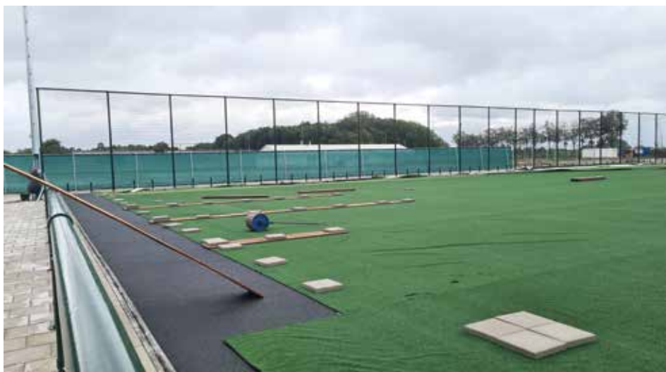
Rond de projectlocatie werden windschermen geplaatst
