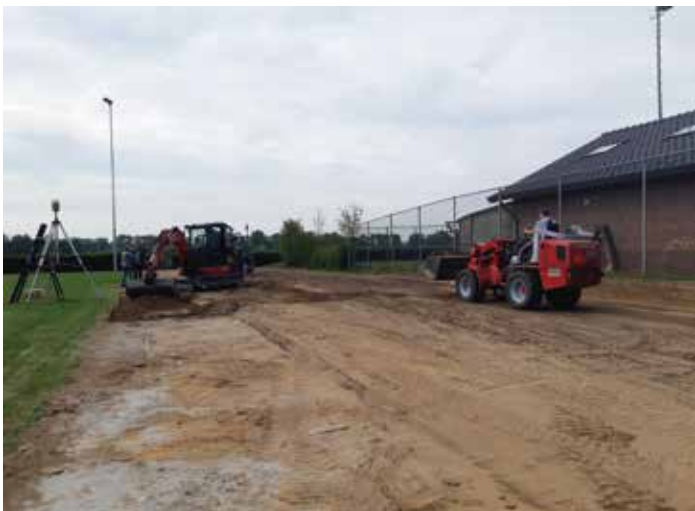
Aannemer Pekkeriet, bezig met het grondwerk
