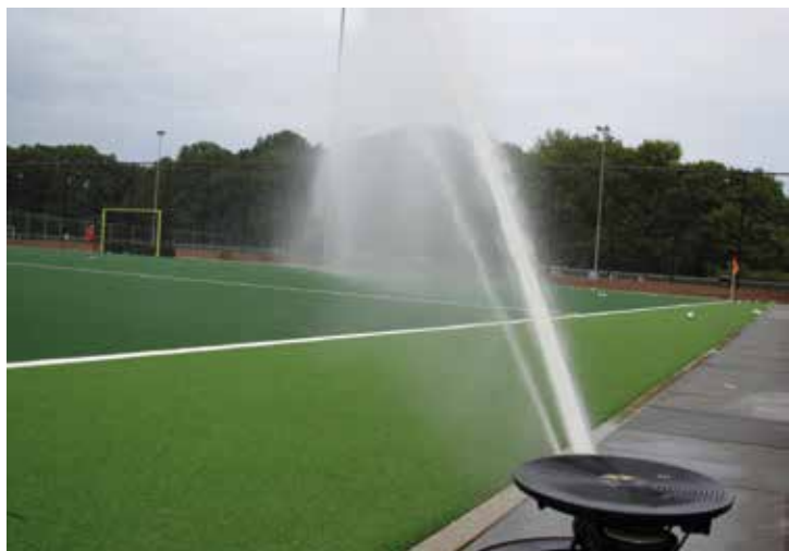
Acht VP3-sproeiers zijn esthetisch weggewerkt in de rand.
