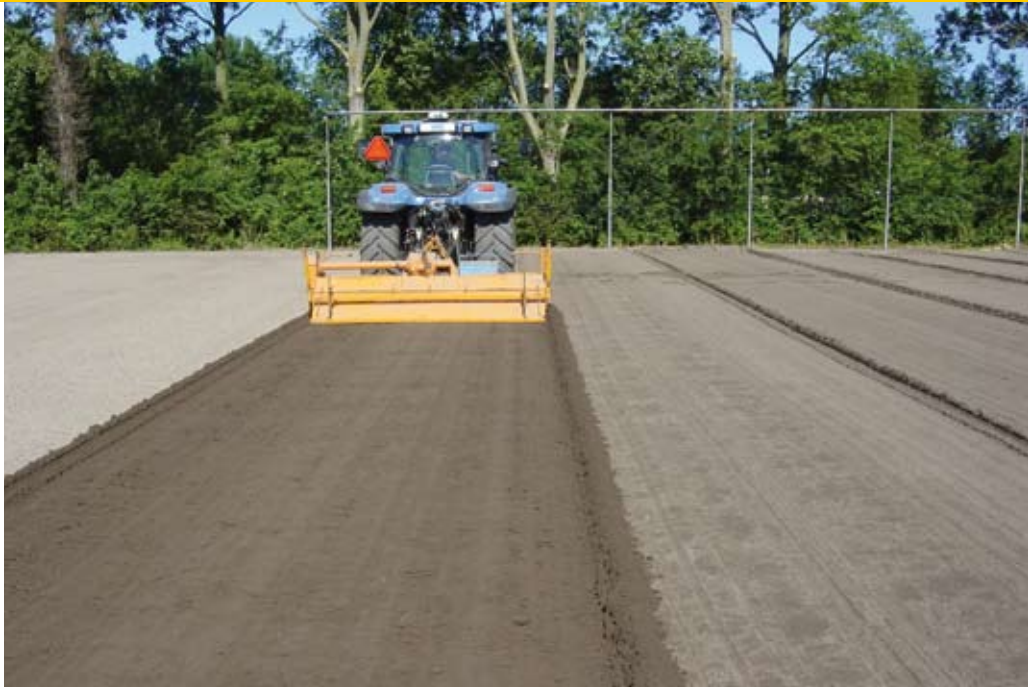
Volleveldstoepassing: 400 ton lava met de hakenfrees doorwerken in bovenlaag in Castricum.
