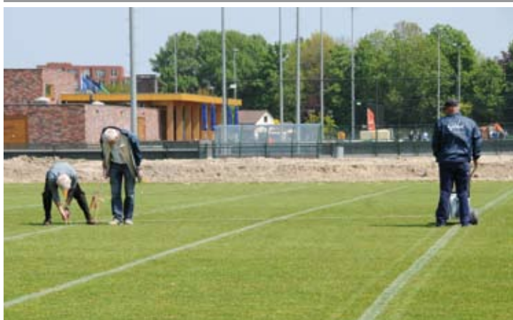
Lijnvast zet met een touw de diameter uit voor een cirkel, die nauwgezet moet aansluiten op de rechte lijn.
