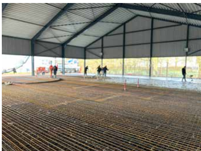
De drie padelbanen in aanbouw
