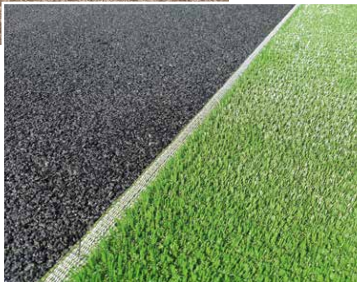
Links de Ecocept-laag, rechts de geweven non-infill-kunstgrasmat
