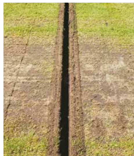
De machine trekt sleuven tussen de 5 en 15 cm
