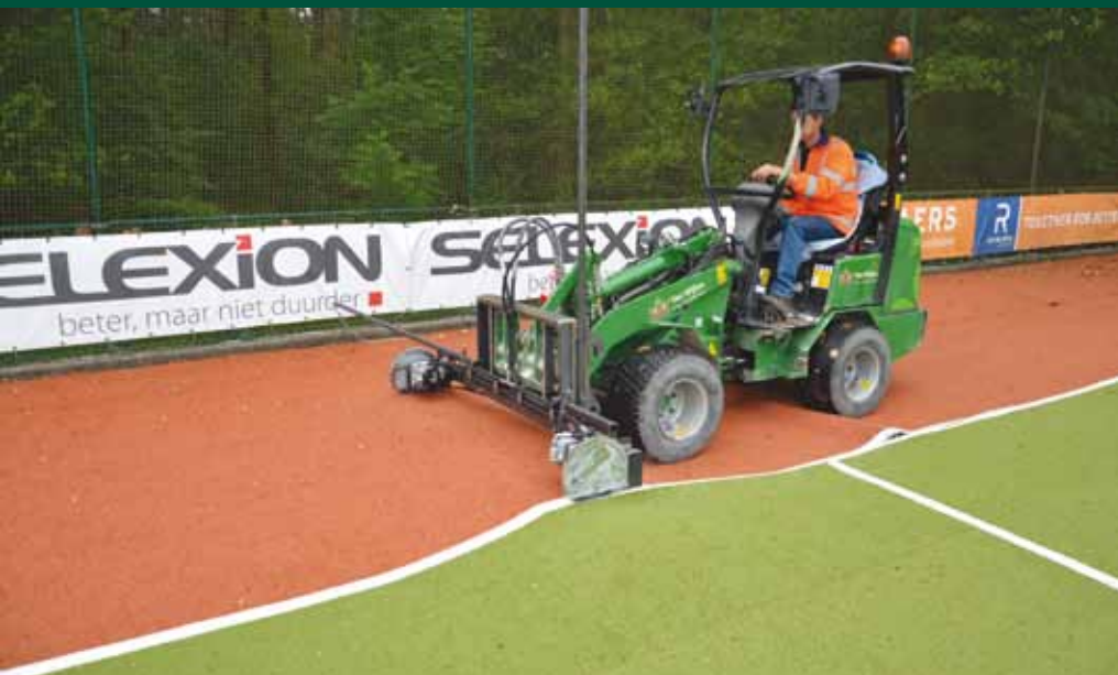
De kunstgrasmat wordt eerst in banen van twee meter breed gesneden, waarna de banen met de wielladers worden opgerold en verzameld.
